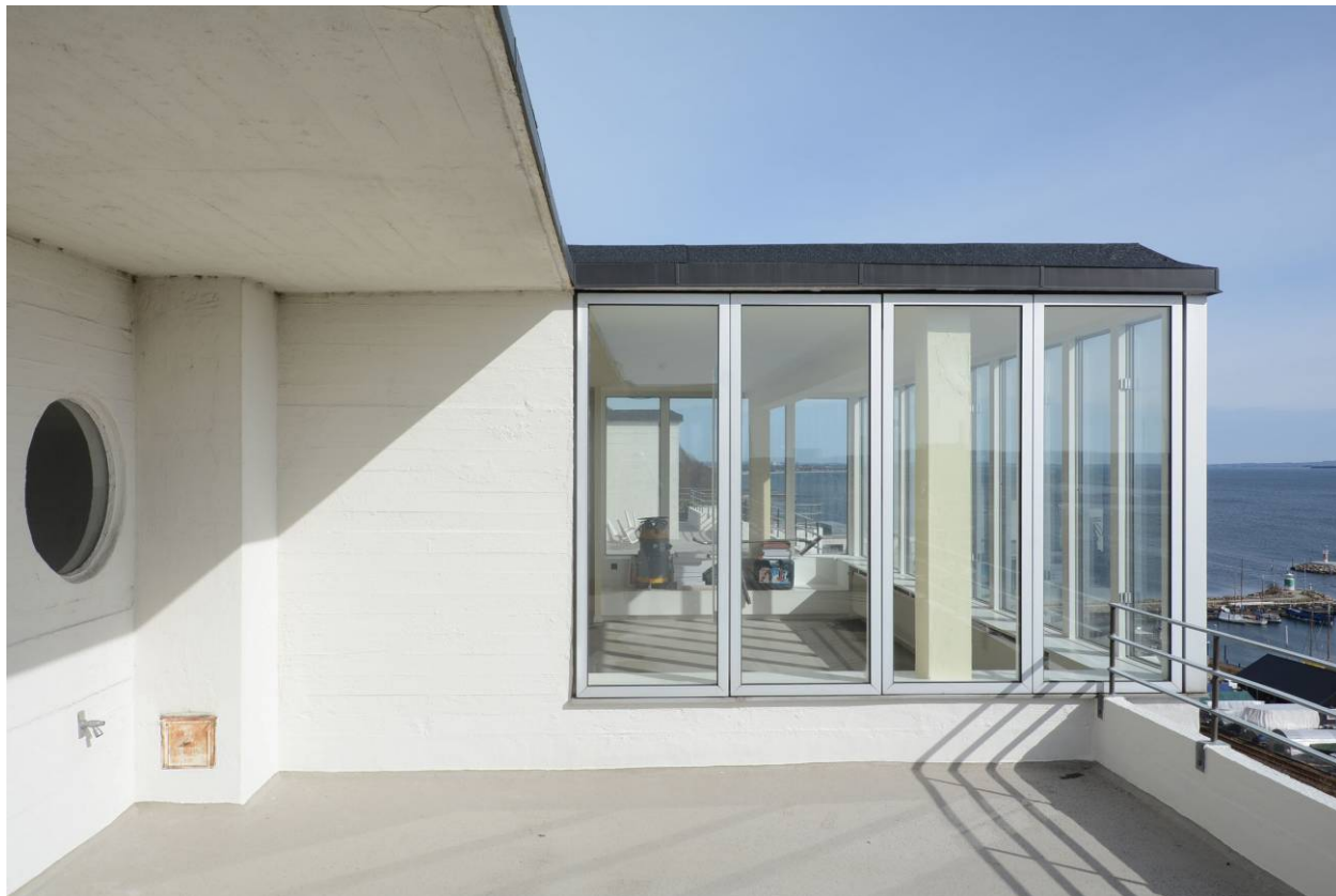
Vinterhaven har Velfac træ/alu-vinduer med en anden opdeling end oprindeligt. Modsat lejlighedernes vinduer, har denne stået med mørke vinduesrammer ud- og indvendigt. Sandsynligvis for at få den til at fremstå mere åben, set nedefra.
