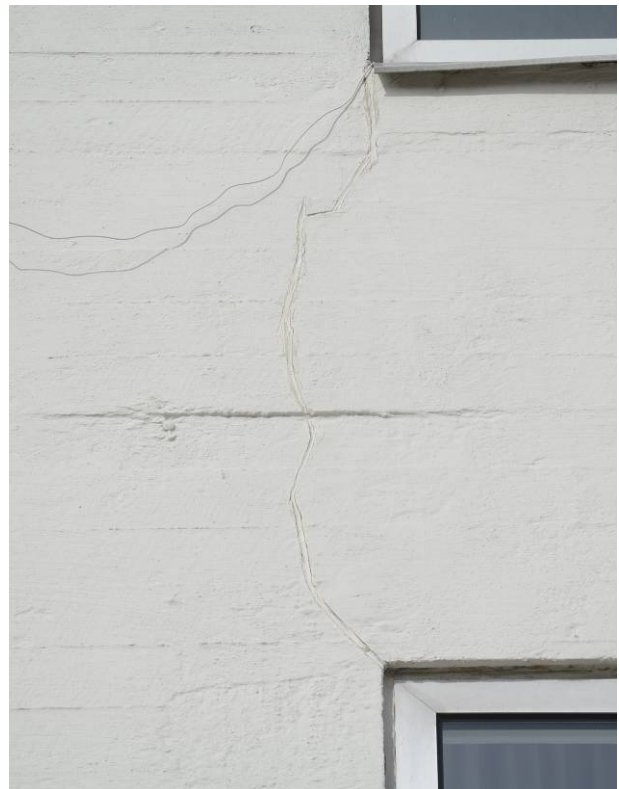
Revner ved vinduesfalsse, som kan være forårsaget af de oprindelige jernvinduer, men også tæring i yderligt liggende armering.
