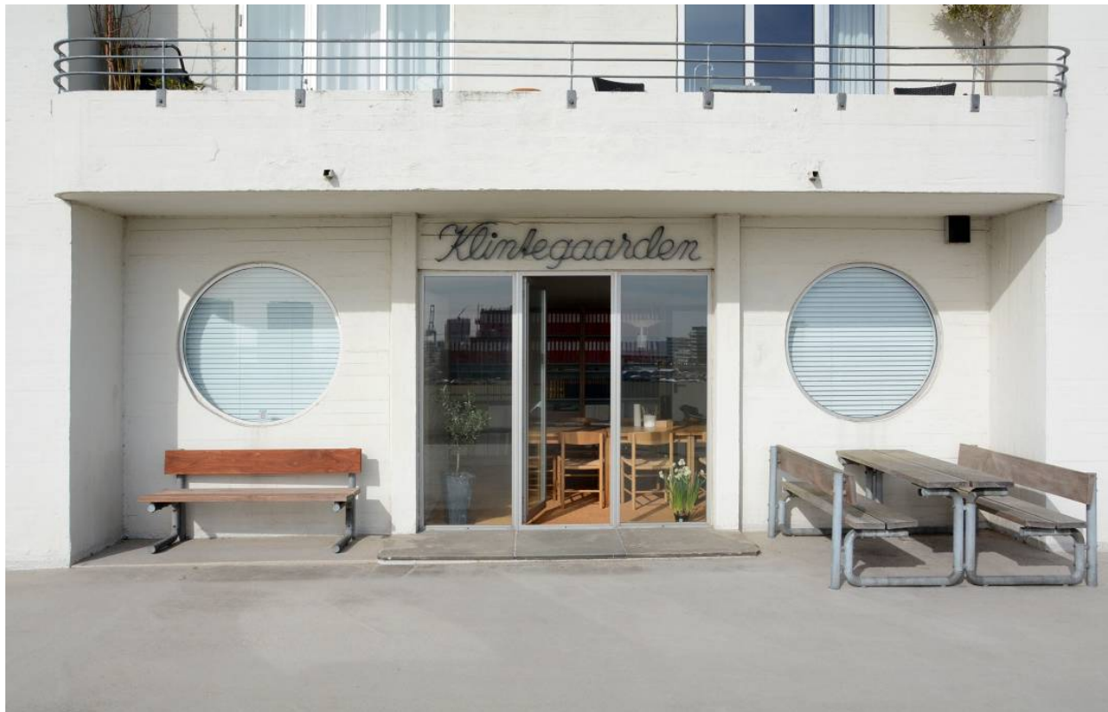
De runde vinduer er i stor udstrækning originale, men de fleste er forsynet med termoruder. Det er uvist hvilken glastype, der har siddet i de store vinduer oprindeligt. Udvendt er disse monteret med en glasliste i aluminium.
